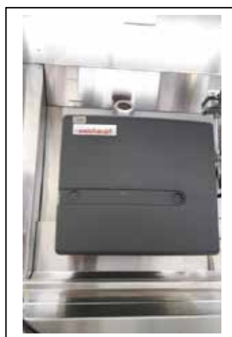
Рис. 4. Штатний пальник вихрового типу
